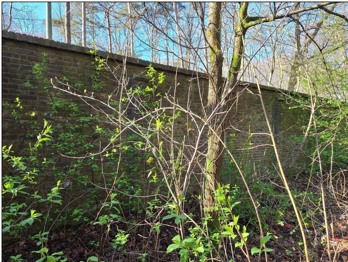
Figuur 2.8. Stenen muur aan de zuidzijde van het plangebied. Deze muur bevat geen holtes, kieren of gaten die gebruikt kunnen worden door de muurhagedis.
